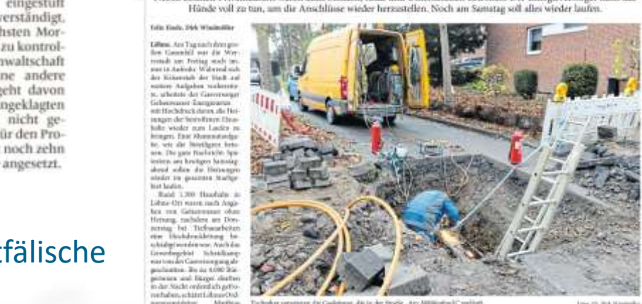
Techniker reparieren die Gasleitung, die in der Straße „Am Mühlentisch“ zerbrach.
